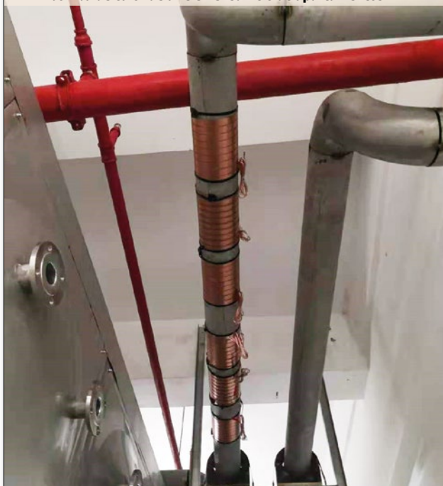
1 equipo Vulcan S100 instalado en el calentador de agua de la bomba de calor de aire en el edificio de apartamentos 1
