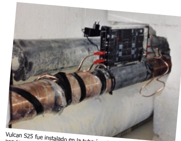
Vulcan S25 fue instalado en la tubería principal de agua para 132 apartamentos
