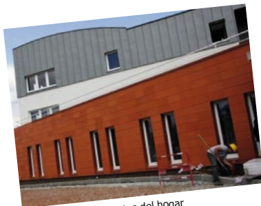
Edificio de apartamentos del hogar
