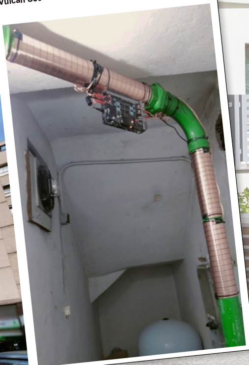
Vulcan S50 en tubo general de agua fría de Ø 76mm
