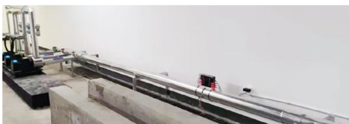
1 equipo Vulcan S100 instalado en el calentador de agua de la bomba de calor de aire en el edificio de apartamentos 10
