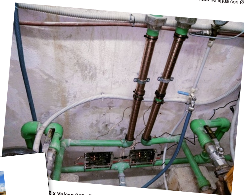
2 x Vulcan S10 En el circuito de agua fría con Ø 41 mm
