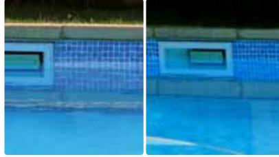
Tubería de agua en una piscina
