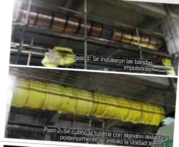
Paso 1: Se instalaron las bandas impulsoras.
