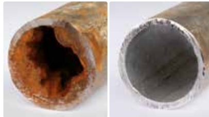
Sistema de tuberías
