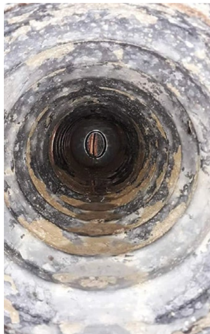
Los depósitos calcáreos se eliminaron fácilmente con una pistola de agua a presión.
