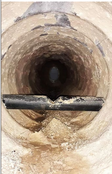
Después de 6 meses de la instalación de Vulcan S25, la caldera se destapó: las incrustaciones de había ablandado y desprendido.
