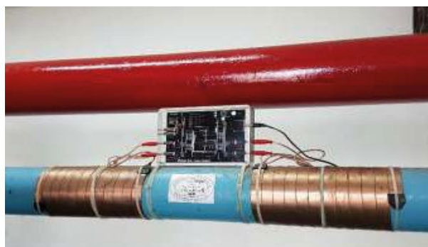
Instalación del sistema Antical Vulcan S25
