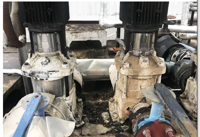
Izquierda: tubería (sin incrustaciones) después de 2 meses de instalación de Vulcan S25. Derecha: tubería sin tratamiento del agua.
