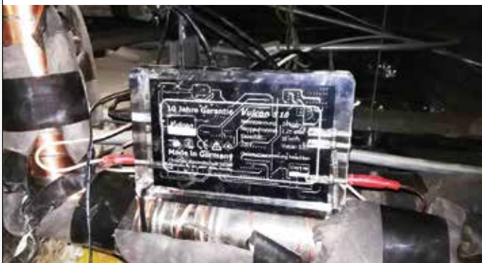
Vulcan S10 instalado en la tubería de agua principal de la cocina china.
